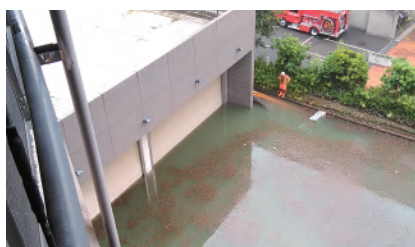
図2 消防による排水作業
