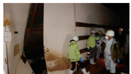
図3 水によって壊れた第3収蔵庫の扉
